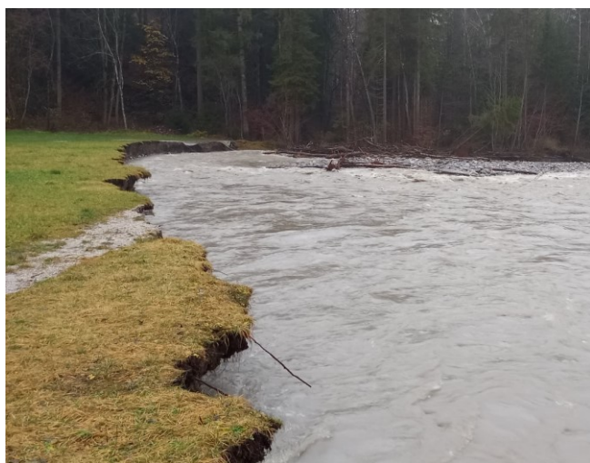
Berge érodée à la suite de la crue
